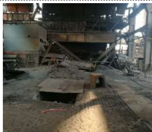
图二 460m 3 及相关设施高炉已拆除
