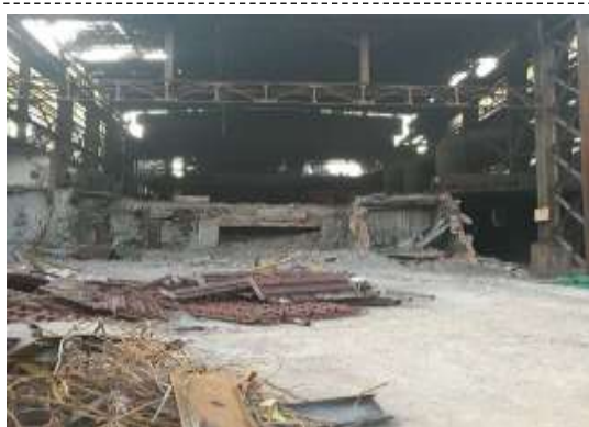
图三 560m 3 及相关设施高炉已拆除
