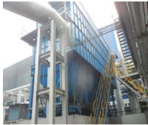
图二十二 焦炉炉头烟气治理措施
