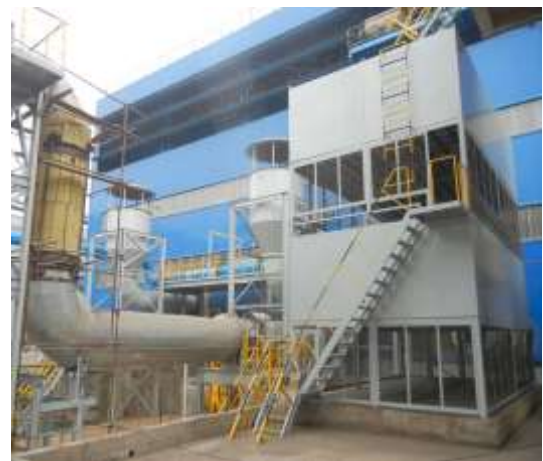
图十六 高炉鼓风机消音器
