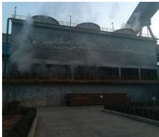
图十一 新水循环冷却系统
