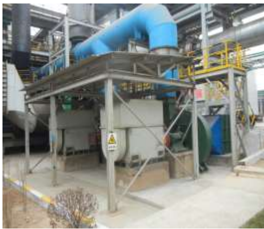
图十七 助燃风机消音器
