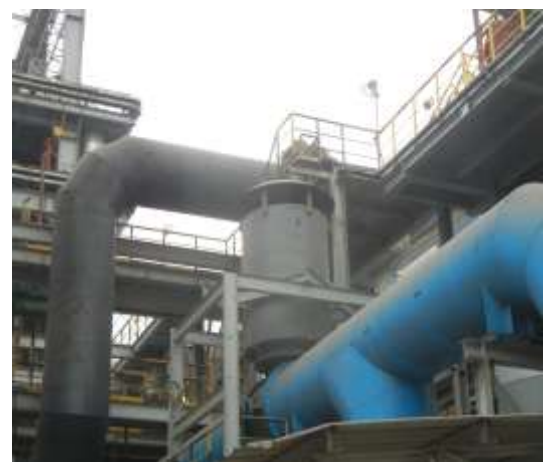
图十八 冷风放风阀消音器
