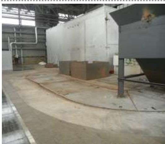
图九 铁沟、渣沟加盖密闭
