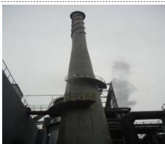
图七 高炉热风炉烟气治理设施
