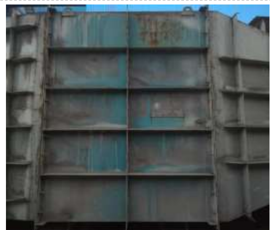
图二十 矿槽除尘风机消音器
